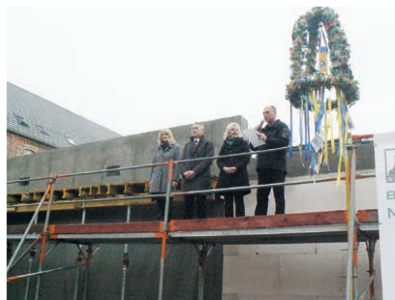
Im Beisein von Schulleiterin Astrid Paschen, Bürgermeister Frank Meier und Landrätin Kerstin Weiss verliest Jens Karsten, Bauleiter der Firma Michael Gabler GmbH Schwerin (v.l.) den Richtspruch für den Neubau am Gymnasium in Neukloster
