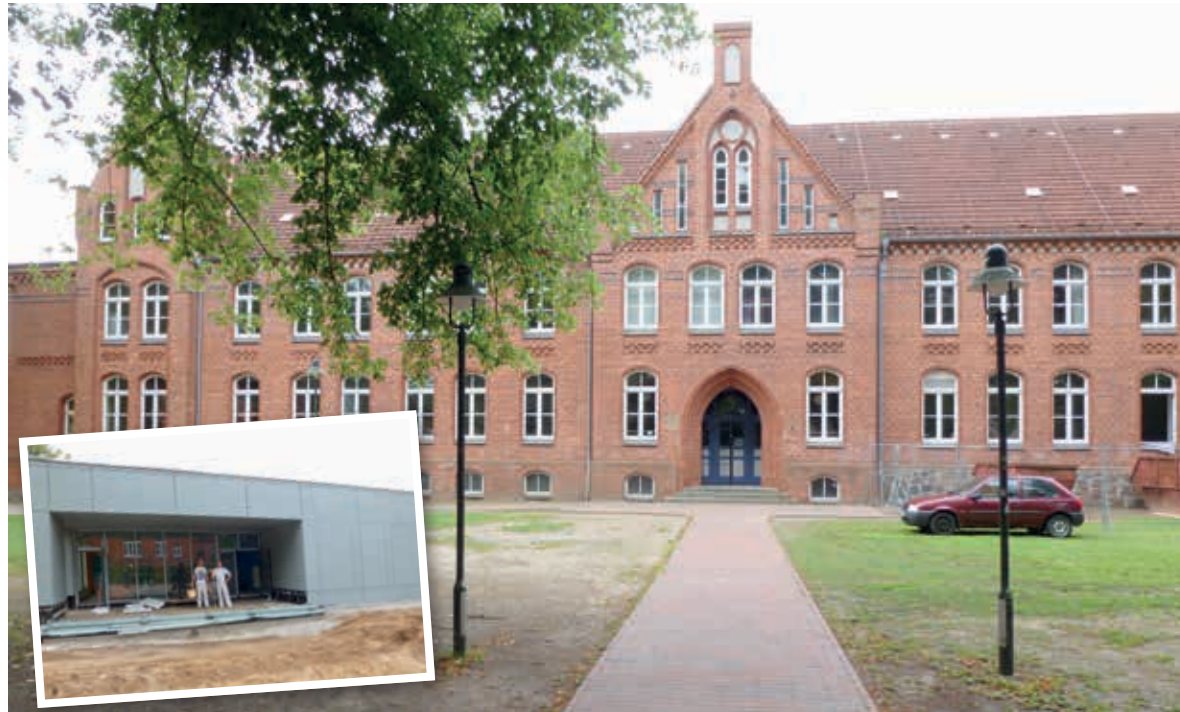
Im Gymnasium "Am Sonnenkamp" in Neukloster wird der Chemietrakt erweitert und es entsteht ein Neubau für den früheren Schulcontainer.
