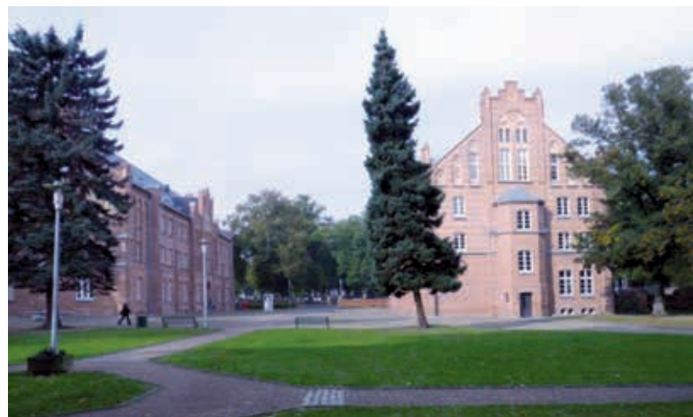
Blick auf das Überregionale Förderzentrum für Blinde und Sehbehinderte
