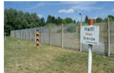
Die Absicherung eines ehemaligen Grenzstreifens ist in der Außenanlage des Grenzhuis in Schlagsdorf zu sehen
