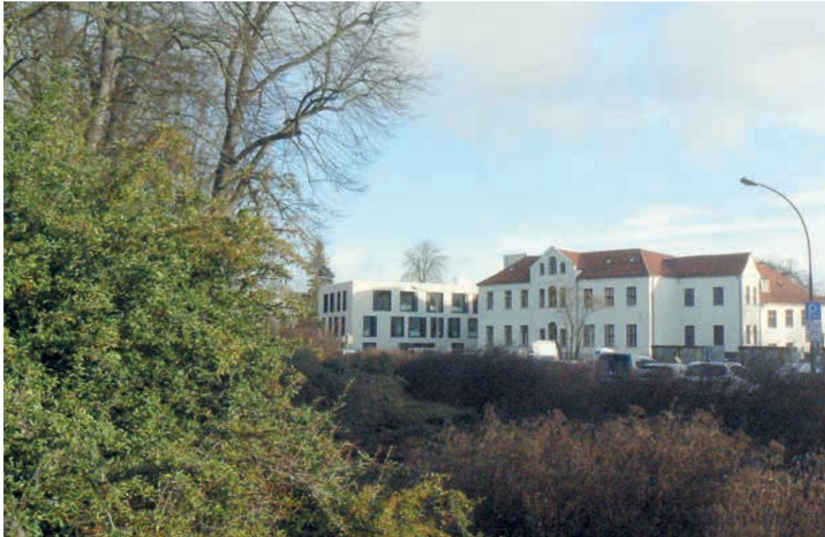
Das Gebäudeensemble des Landkreises Nordwestmecklenburg am Kreissitz in Wismar, Rostocker Straße 76
