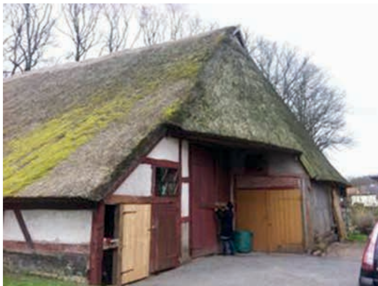
In die zwischenzeitlich denkmalgerecht sanierte Pfarrscheune am Pfarrhof Dorf Mecklenburg soll ein öffentlich nutzbarer „Raum im Raum“ eingebaut werden, der gemeinsam von Kommune und Kirchgemeinde genutzt werden kann und sich zum Kulturpunkt der Gemeinde entwickeln soll. Foto: Monika Seitz
