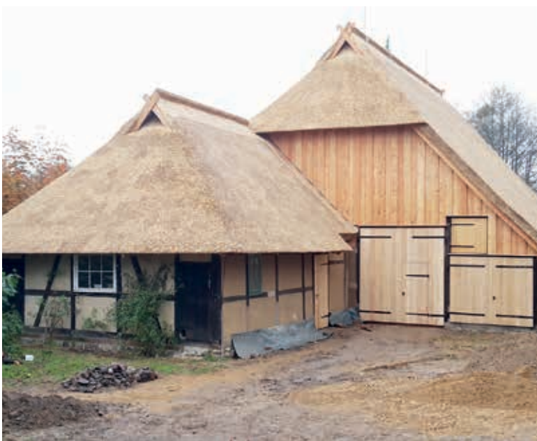
Sanierung der Pfarrscheune Cramon (Foto: Kerstin Pressler)
