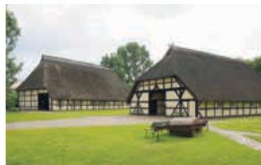
Das Volkskundemuseum verfügt neben seiner einzigartigen Sammlung an Mobiliar und Textilien über eine besondere Außenanlage. Die Scheune und das Schulzenhaus sind die ältesten Hallenhäuser Mecklenburgs aus der Zeit um 1500.
