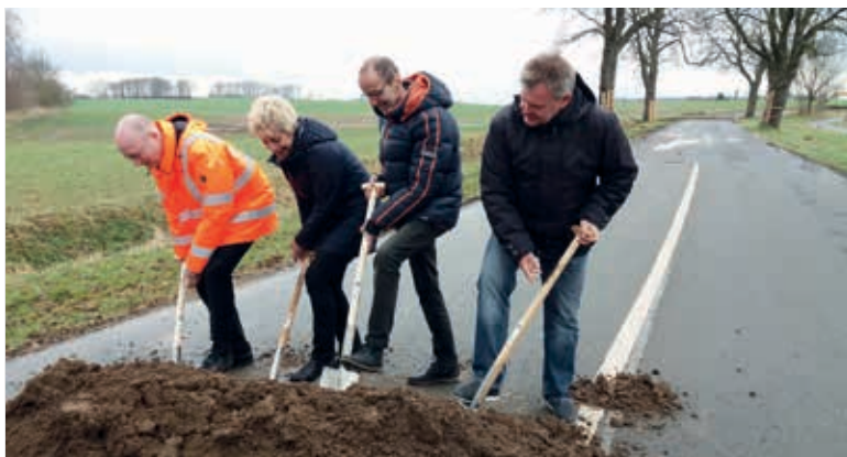
Minister Christian Pegel, Landrätin Kerstin Weiss, Bürgermeister Andreas Possekel und Uwe Backert vom Straßenbauamt Schwerin beim ersten Spatenstich für den Ausbau der Kreisstraße von Grambow nach Wittenförden.
