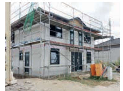
Rege Bautätigkeit in Nordwestmecklenburg: Unser Foto zeigt das neue Wohngebiet „Am Mühlenbruch“ in Selmsdorf.
