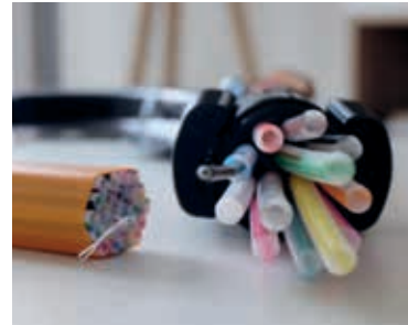
Verlegt wird Glasfaserkabel.
