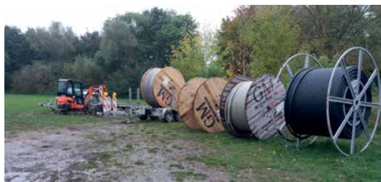
Momentaufnahmen beim Breitband-Ausbau in Barnekow (oben) und auf dem Parkplatz an der Wohlenberger Wiek
