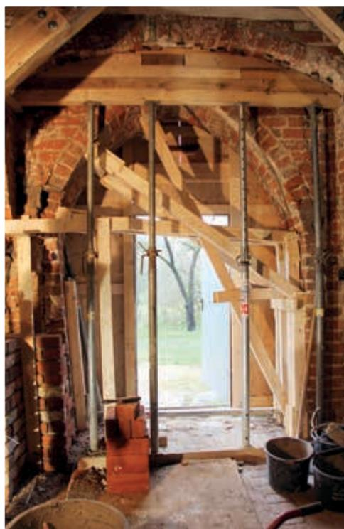
Um das Portal sanieren zu können, musste aufwendig abgestützt werden.
