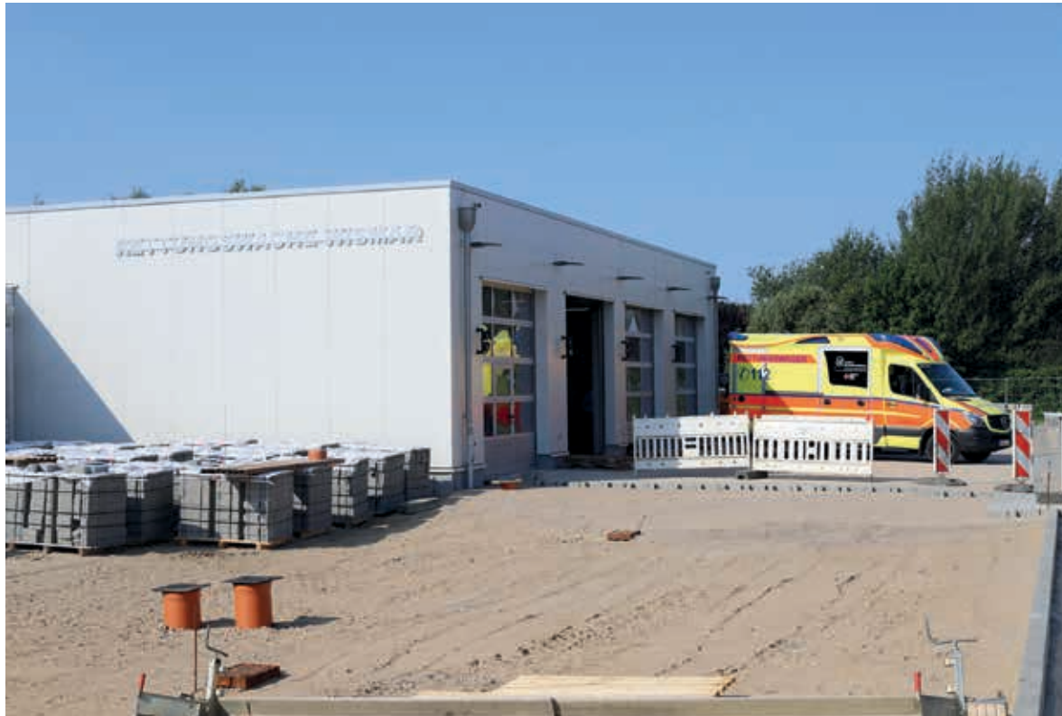
Die neue Rettungswache Wismar: Bei der Einweihung mussten noch Restarbeiten an den Außenanlagen erledigt werden.
