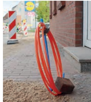
Die Tiefbauarbeiten im Landkreis Nordwestmecklenburg sind zu 95 Prozent abgeschlossen. Foto: WEMAG/Reiber
