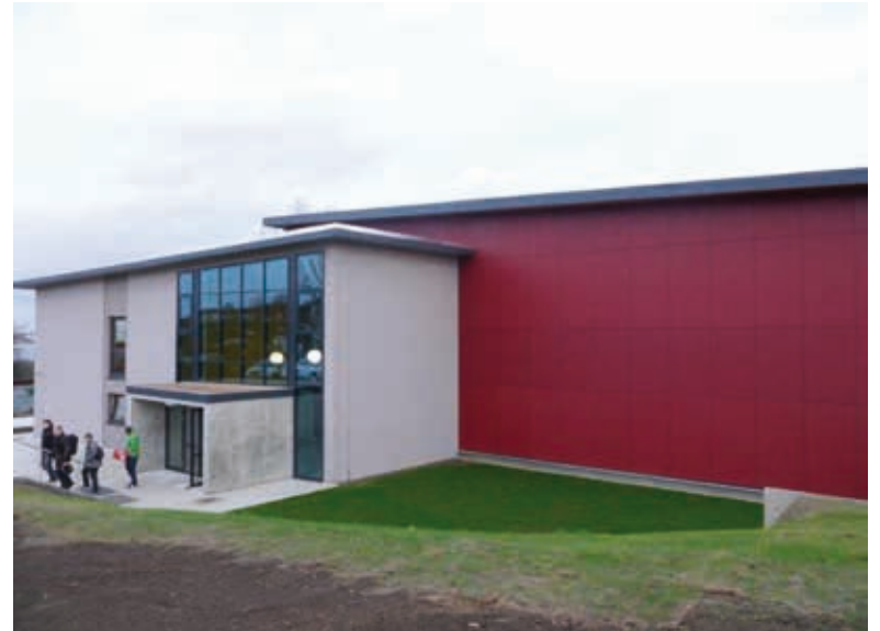
Die Außenansicht der neuen Zweifeldhalle des Berufsschulzentrums Nord in der Wismarer Lübschen Straße
