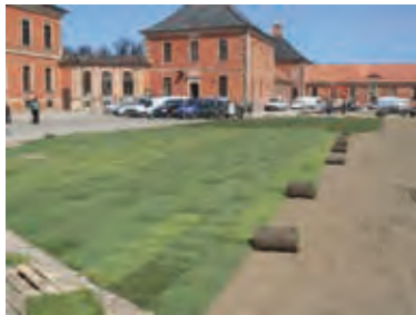
23. April 2015: Der Rollrasen im Ehrenhof wird verlegt.
