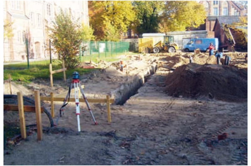
Die Erdarbeiten für den Ersatzneubau des Gymnasiums „Am Sonncamp“ in Neukloster haben Ende Oktober begonnen. Foto: LK NWM
